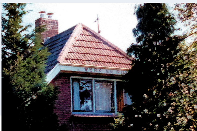
Voorgevel met de tekst; Werk en Rust.
